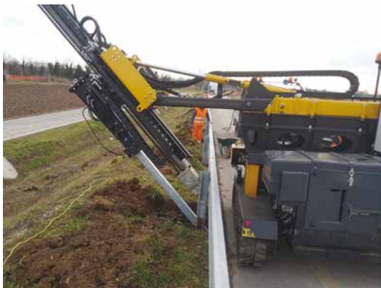
9A e 9B. L'installazione di ATOS (9A) e un particolare (9B)
